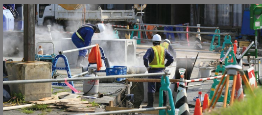
土木・工事現場
